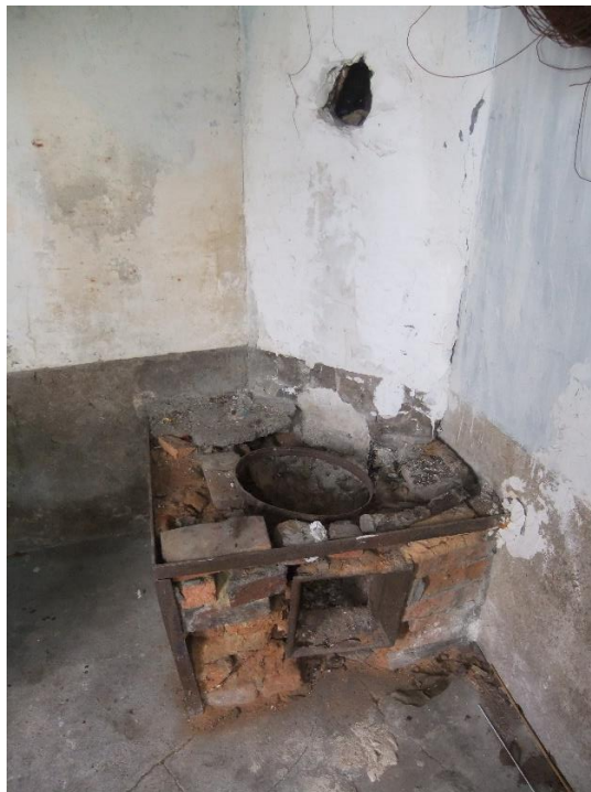
Le fourneau de la buanderie pour poser les lessiveuses
