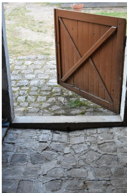
Le jeu des pavés de grès, à l'intérieur et à l'extérieur de l'écurie.
